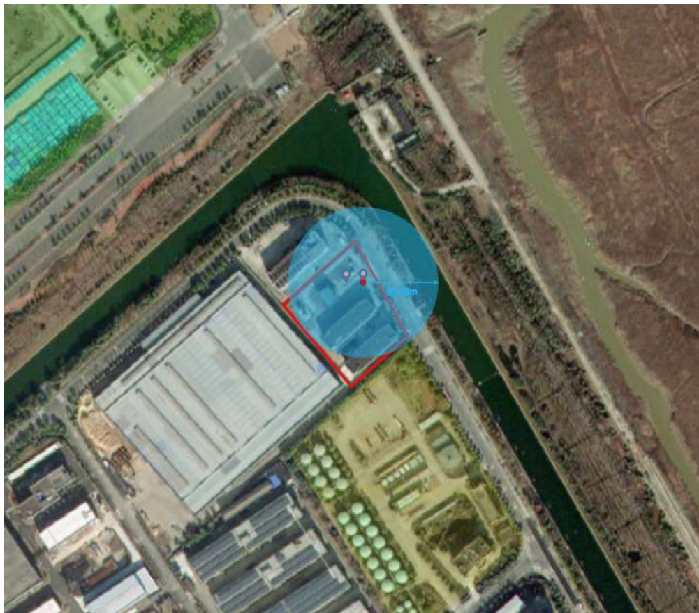
附图 2.2-8 液氨槽罐车-装卸软管完全破裂—喷射火灾—常压容器的模拟图
