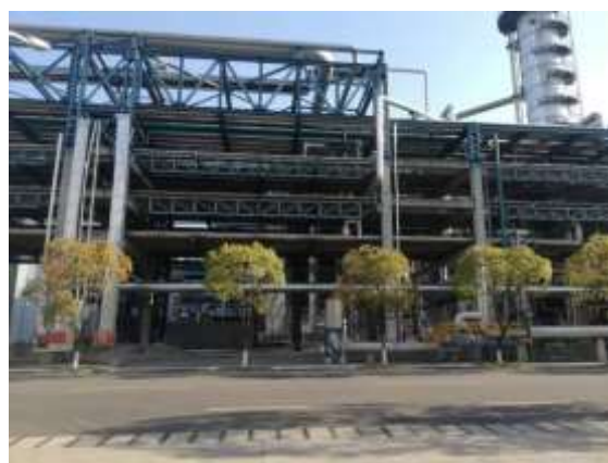
东侧的 1#渣油加氢装置
