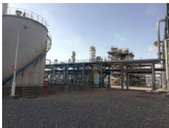
南侧的裂解汽油加氢装置
