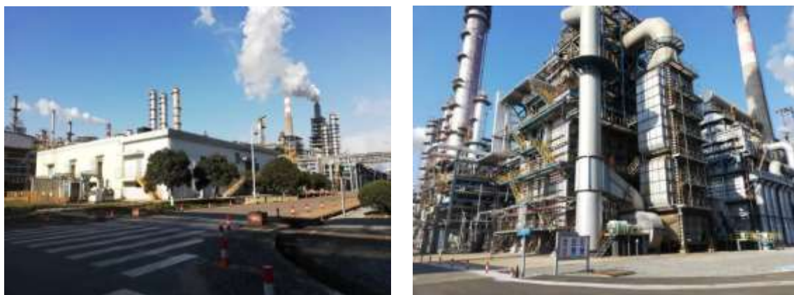
西侧的加氢装置和区域变电所
