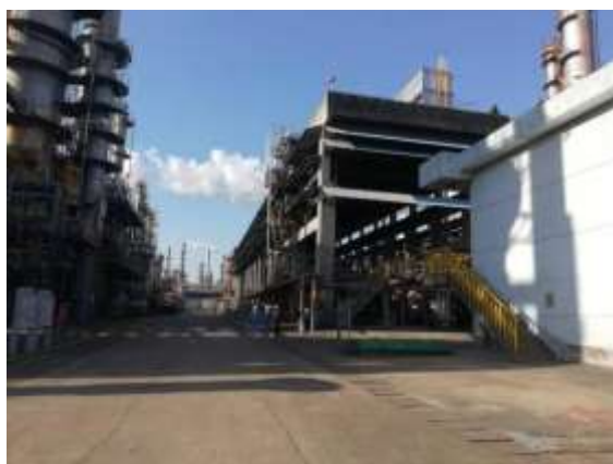
2#轻烃回收及氢回收装置现状
